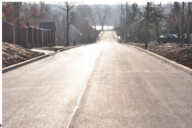
ul. Żytnia po przebudowie
